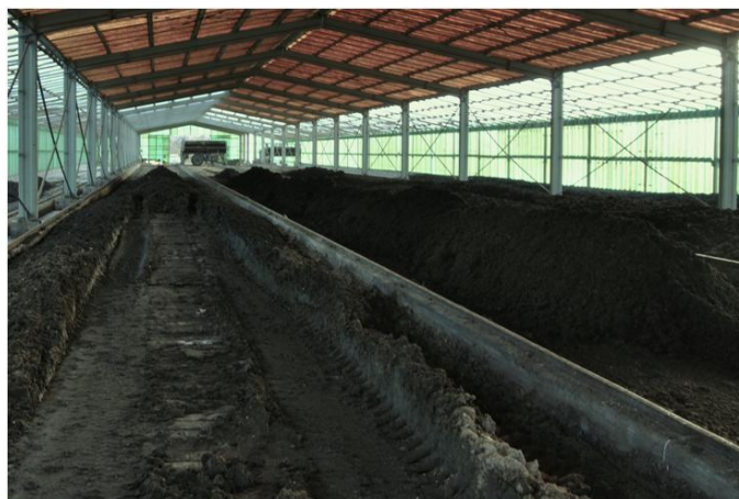
Figura 11. Estabilizado cubierto del GAP Fuente: Propia
