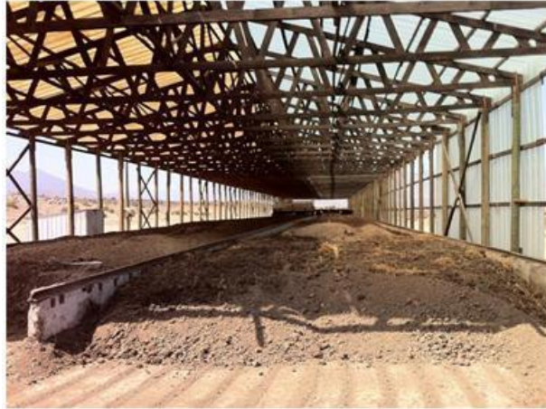
Figura 12. Estabilizado cubierto del GAP con movimiento de maquinaria Fuente: Propia
